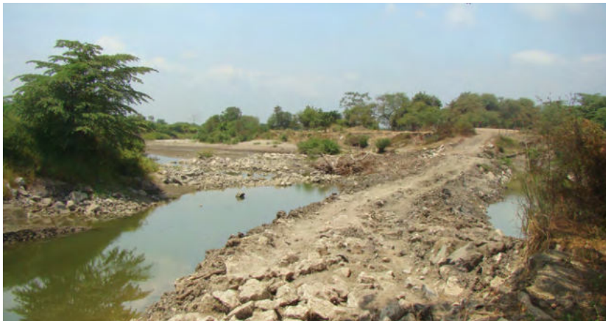
Foto 4. Zona de degradación en el río Magro.
