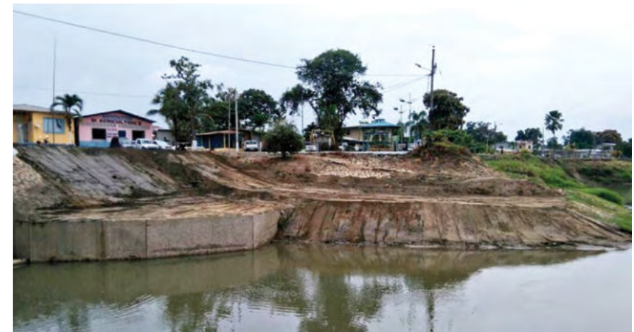
Fotos 6 y 7: Dragado de la estación de bombeo de la Junta de Usuarios San Jacinto; Fuente: DIDRA-GADPG
