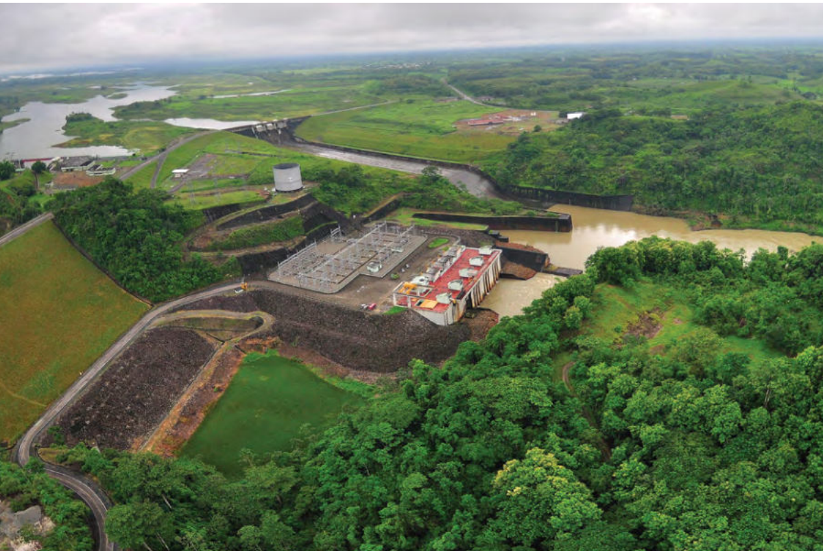
Foto 1: Represa Daule Peripa. Fuente: CELEP EP, 2016
