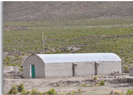
Invernadero comunal concluido en la comunidad Otuyo (Salinas)
