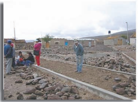
Realizando un seguimiento a la ejecución del proyecto “Mejoramiento de la Plaza, para el turismo comunitario” en la Comunidad Coqueza (Tahua).
