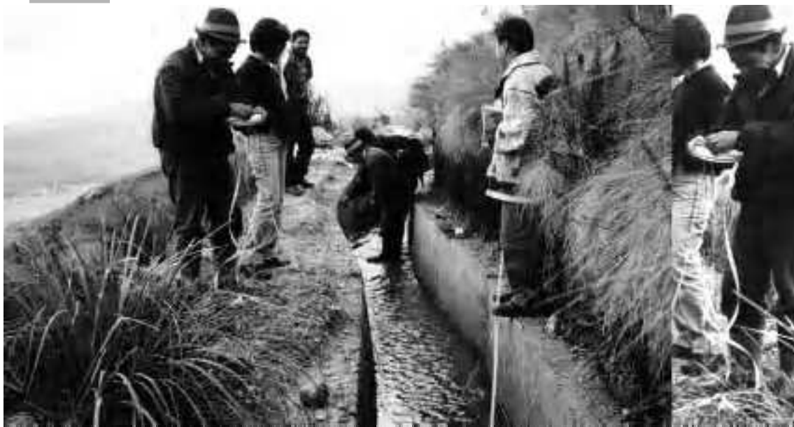
FOTO 6: FISCALIZACIÓN DE OBRAS EN EL CANAL CHIRIPUNGO
